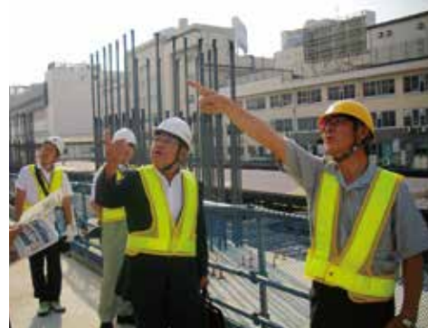
新潟駅工事視察 新潟駅同一ホーム乗り換え工事視察
