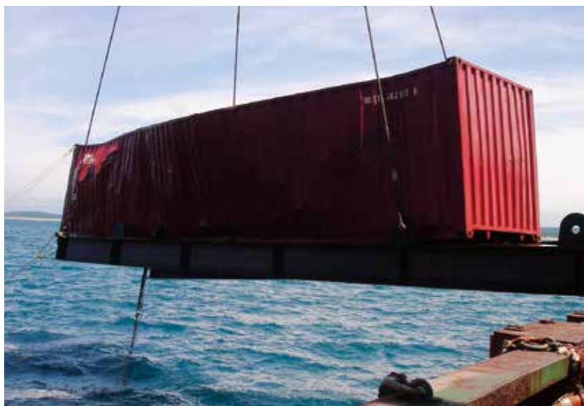
H18. コンテナ引き上げ撤去作業視察①
