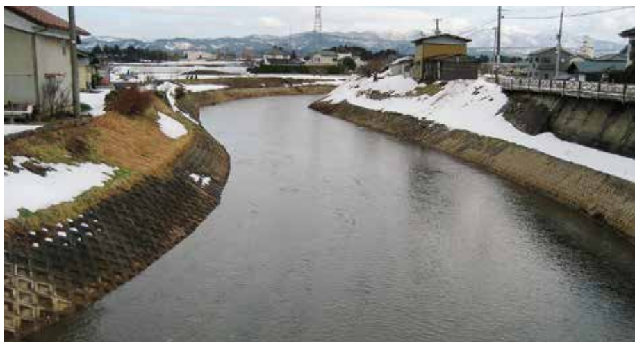
浚渫完了した今野川
