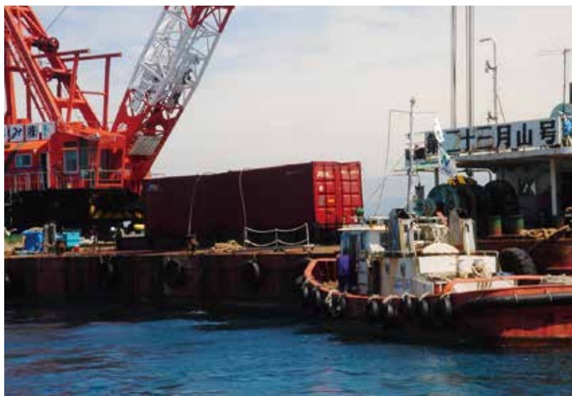
H18. コンテナ引き上げ撤去作業視察②
